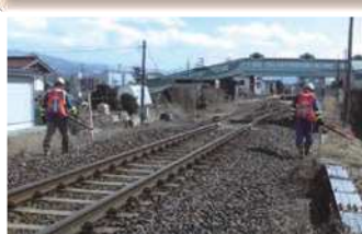
線区・除草剤散布
