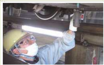
フサギ板取付作業
